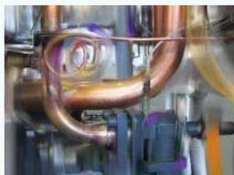
Si tratta di una **caldaia progettata e realizzata a Pordenone**, in sostanza è una pompa di calore ad alta temperatura, in grado di produrre acqua calda superiore ai 75°C.
